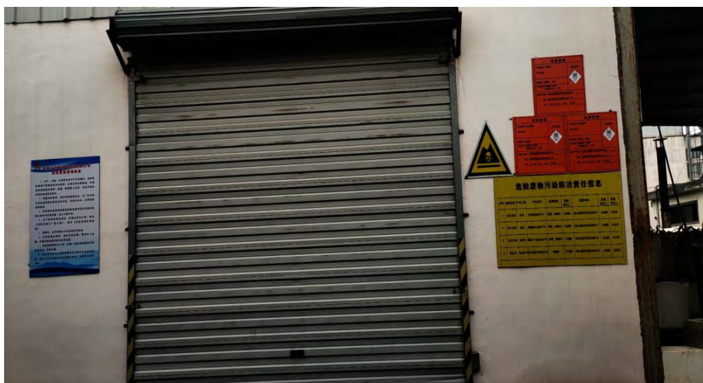
危废品暂存库
